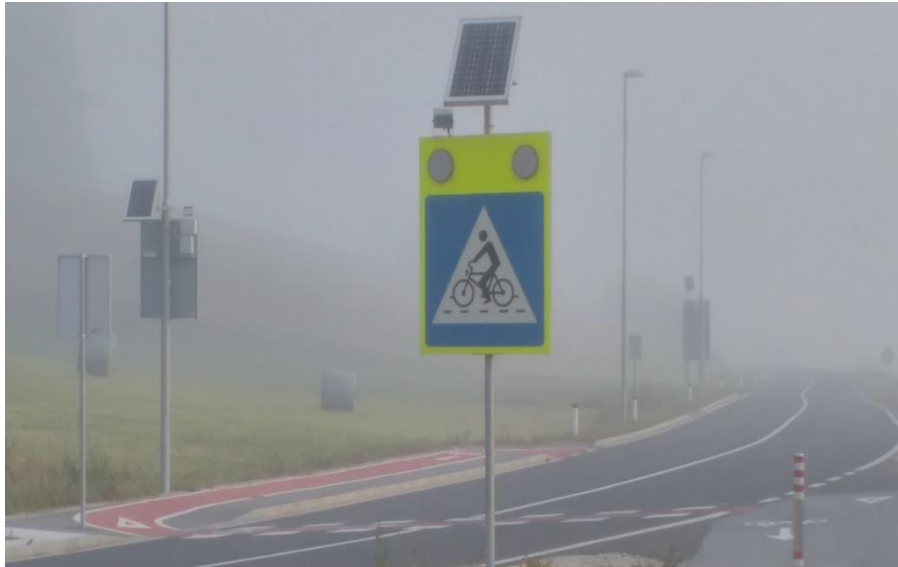
Slika 74: Prehod kolesarjev pri nadvozu Grobelno
