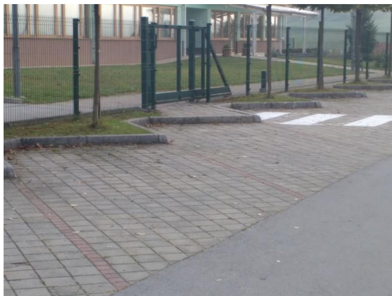
Slika 21: Neprimerna lokacija parkirnega prostora
