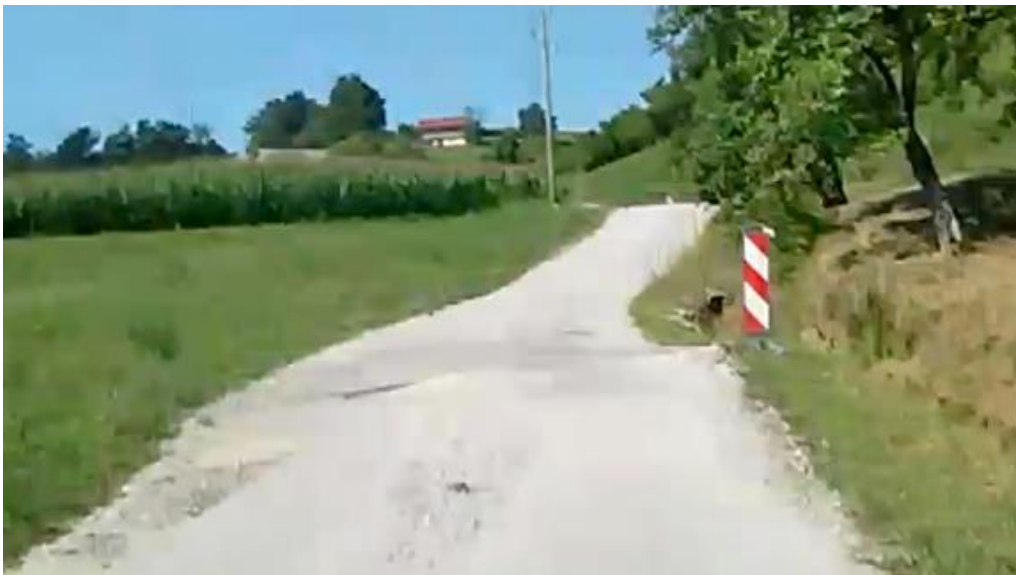
Slika 62: Poškodovana cestna infrastruktura
